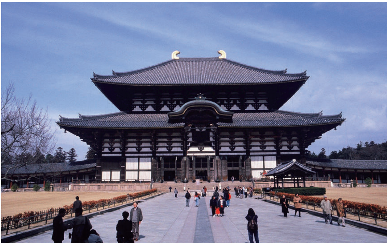
Fig. 2: O Templo Todaiji em Nara, a maior estrutura de madeira, foi reconstruída entre 1121 e 1206. Fotografia do autor.
