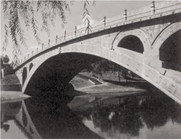
Ponte de Anji, província de Hebei, construída entre 605 e 607, a mais antiga ponte de arco segmentado do mundo. In La Chine Ancienne , Bordas, Paris, 1988.
