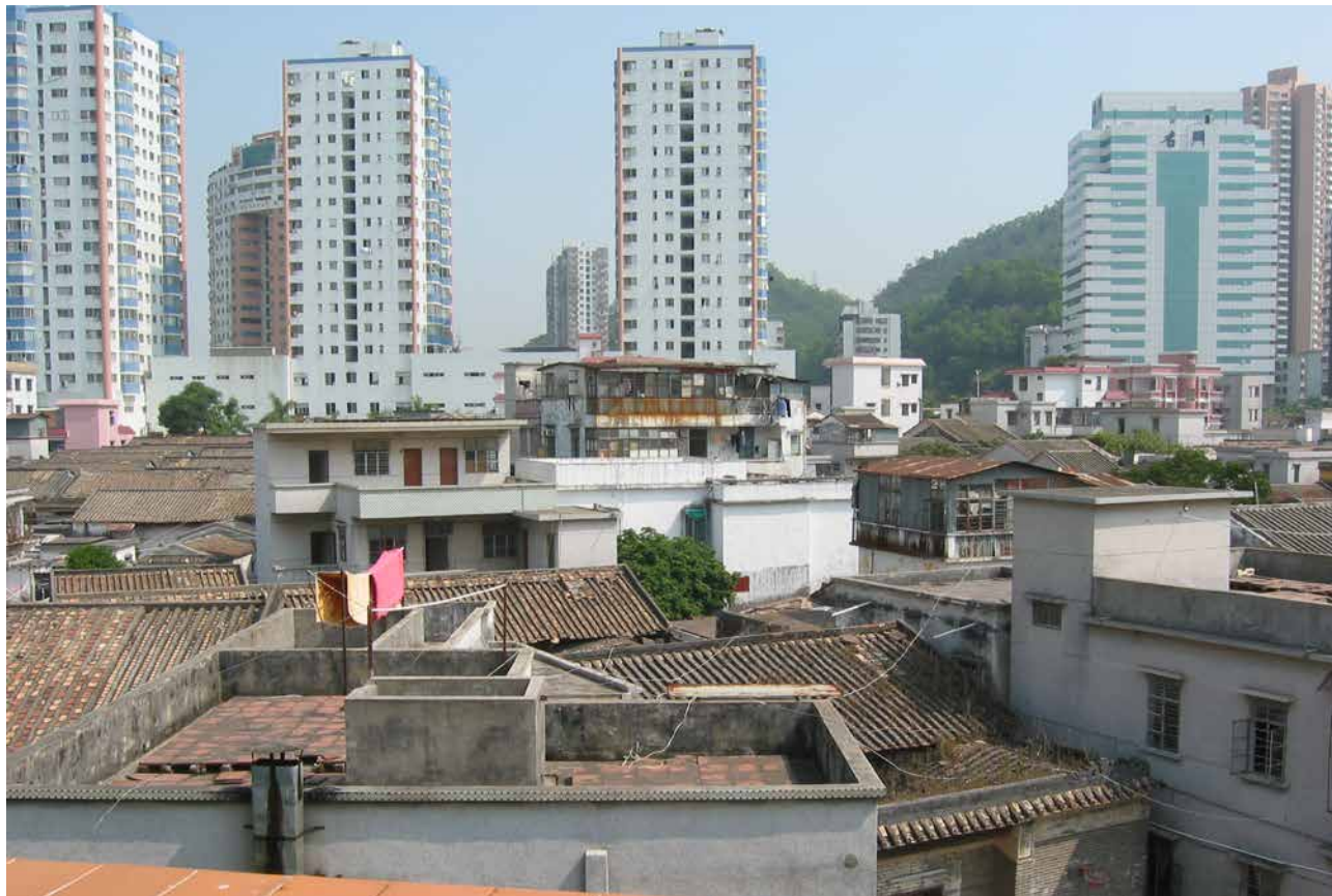
圖 4. 珠海北嶺村拆遷前相片（圖片來源：湯慶文攝於 2003 年）
