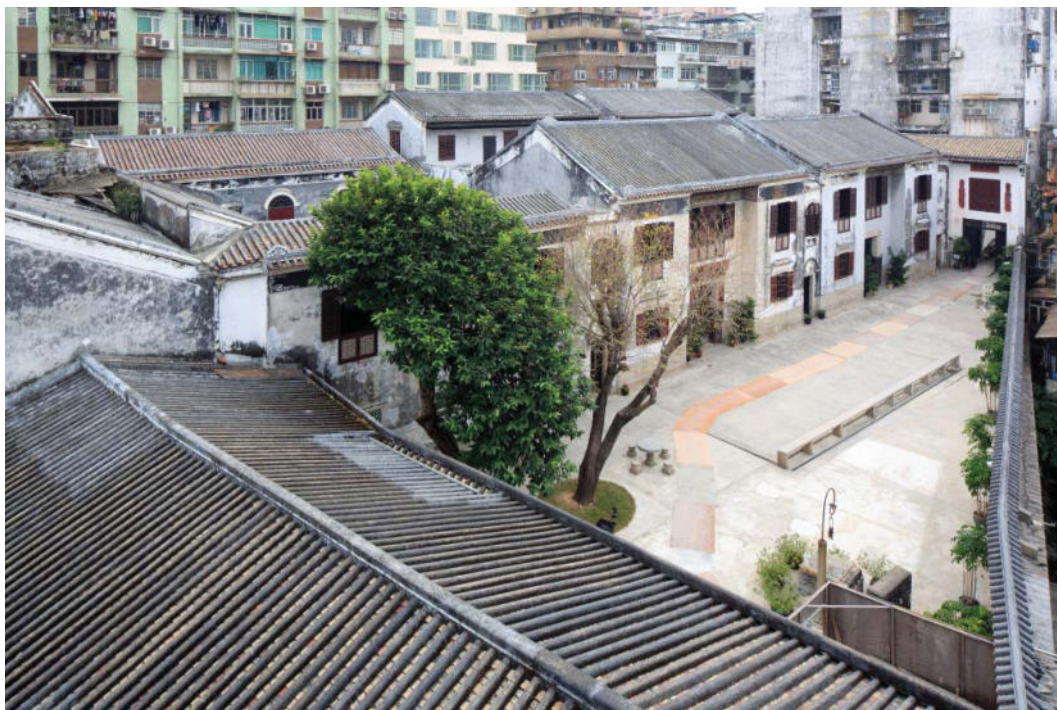
世界遺產鄭家大屋修復後照片
