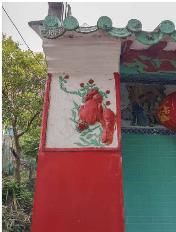
圖 11. 廟宇的夯土牆（左圖）厚度超過 70 厘米，正面有寬厚的山牆墀頭（右圖）。（圖片來源：筆者攝製提供）
