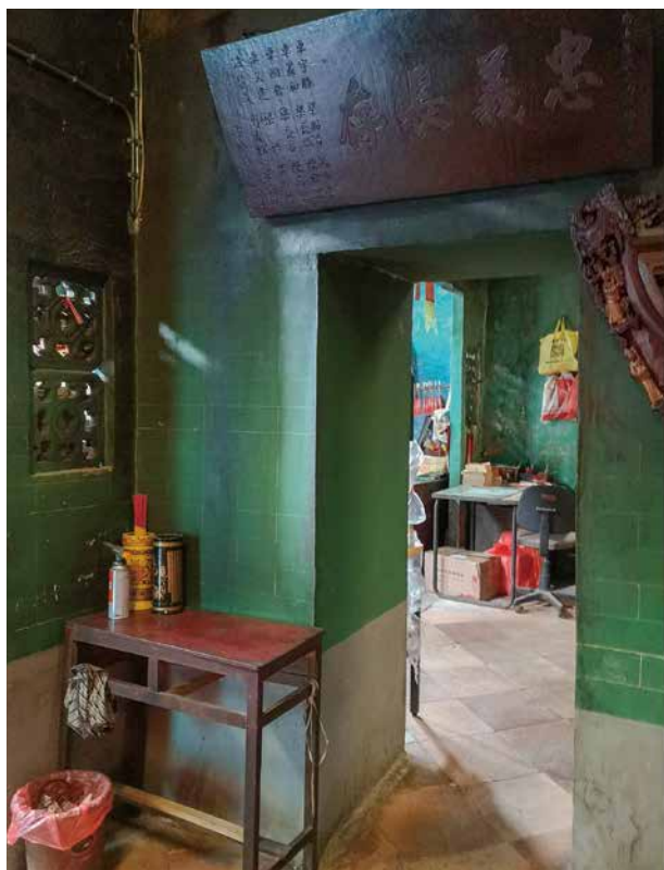
圖 11. 廟宇的夯土牆（左圖）厚度超過 70 厘米，正面有寬厚的山牆墀頭（右圖）。（圖片來源：筆者攝製提供）
