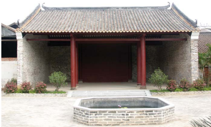
〔圖5〕2007年底王公生祠前殿維修竣工照片（王超傑攝）
