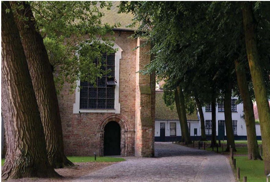
布魯日伯格音修院 (the Beguinage "De Wijngaard" in Bruges) 伯格音修院中的教堂
